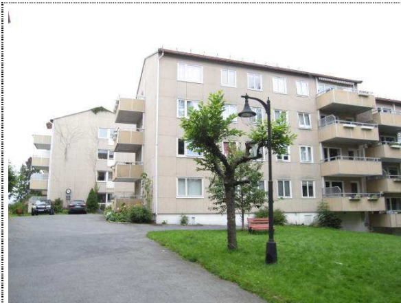
Bilde nr. 1 - Fasadene ble rehabilitert på 1980-tallet. Fasadene er kledd med Steniplater.
