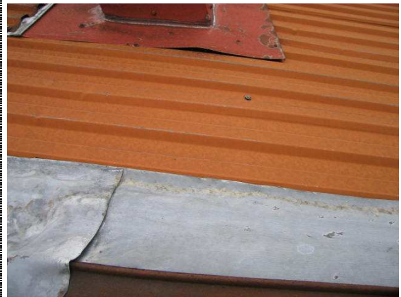
Bilde nr. 38 - Kontroll av taket bør utføres i løpet av 5 år.
