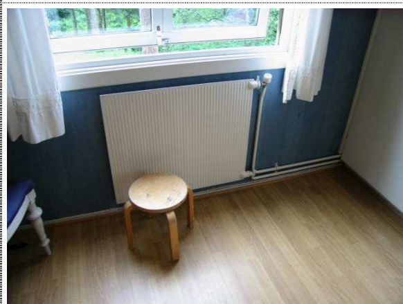
Bilde nr. 33 - Typisk radiator med manuell kran i leilighet.
