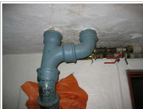
Bilde nr. 41 - Originale avløpsrør og vannledninger.
