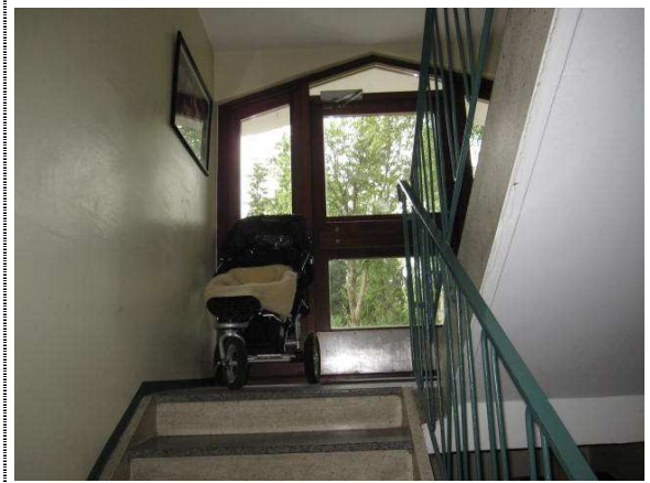
Bilde nr. 18 - Generelt mange barnevogner som står i trapperommet. Boligsameiet har behov for å bygge boder på utsiden til barnevogner og sykler.
