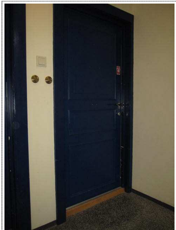
Bilde nr. 8 - Leilighetene har klassifiserte B30 dører fra slutten av 1990-tallet.
