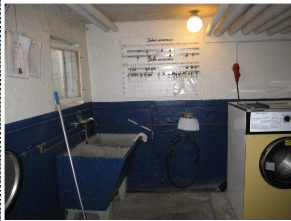
Bilde nr. 17 - Vaskerom i god stand. Kun behov for periodisk vedlikehold av vegger, himlinger og gulv.
